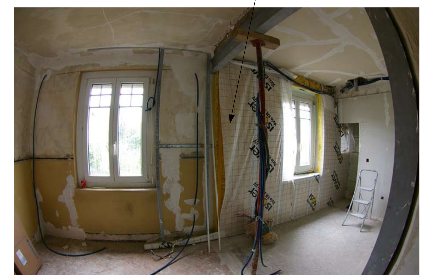
Isolant et frein-vapeur en cours de pose
