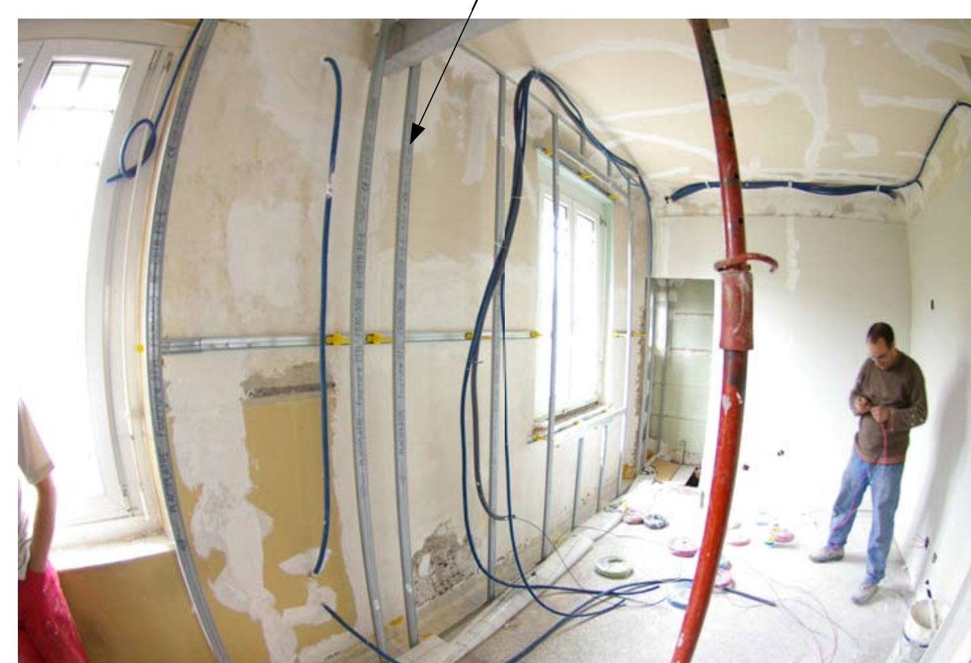
Mise en place de la structure métallique
